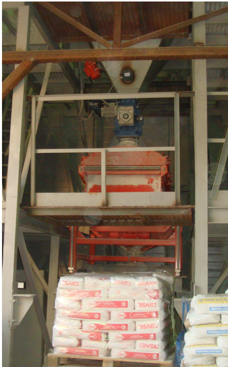
Завод сухих строительных смесей.
